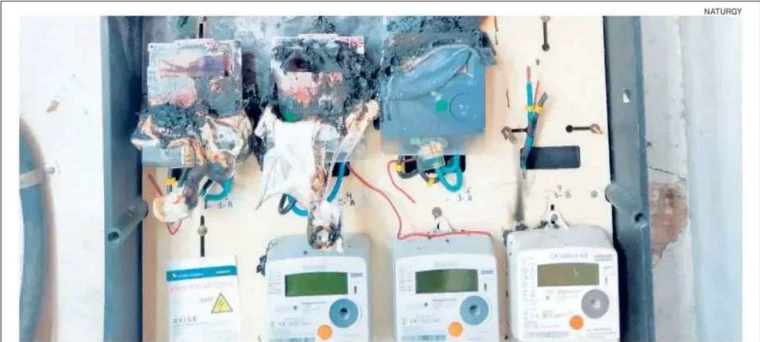
Las conexiones irregulares a la red son una importante fuente de siniestros eléctricos
